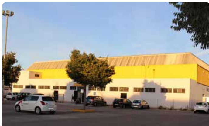
PABELLÓN DE VOLEIBOL MUNICIPAL
