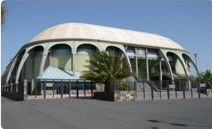
PABELLÓN SANTA LUCÍA DE TIRAJANA 2500 ESP. Avda. Las Tirajanas, s/n (Sª Lucía de Tirajana) Teléfono - Fax 928 795280
